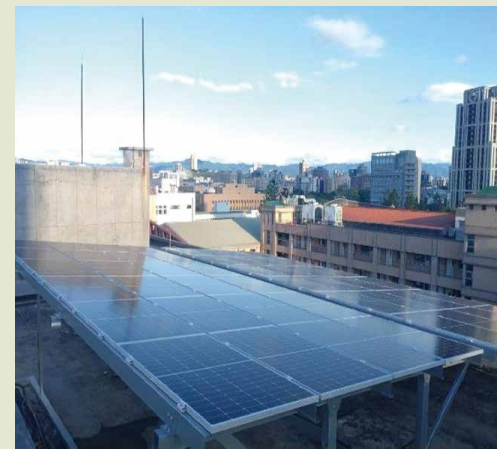
城中校區屋頂設置太陽光電發電設備
