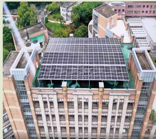
雙溪校區屋頂設置太陽光電發電設備
