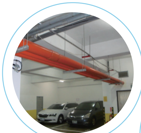
大樓污水管與污水下水道連結
